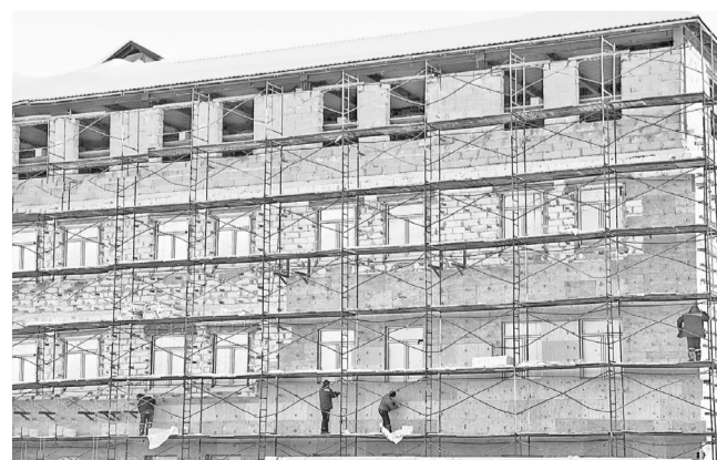
Фасад здания будущего загса обшивают минеральной плитой, ведётся установка стеклопакетов. Фото: Зинаида Исаева, ГТРК «Вектор».
